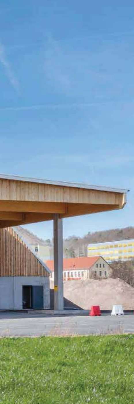
◀ Die Salzlagerhalle in Sondershausen besteht aus Stahlbeton-Schüttwänden bzw. eingespannten Stützen, auf die ein Satteldach aufsetzt
