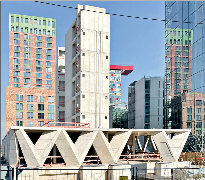
Start für die Montage des ersten Obergeschosses nach Errichtung des Erdgeschosses und der Erschließungstürme in Stahlbetonbauweise Foto: HPP Architekten
