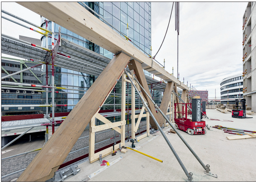
Montage eines Fachwerk-Fassadenträgers im ersten Obergeschoss Foto: Ansgar van Treeck
