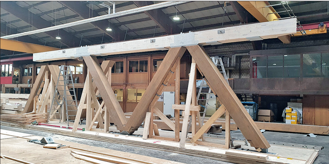
Vorfertigung des Fassadenfachwerks aus Lärche bei Derix: links ein schmales, rechts ein tiefes V-Stützenelement
