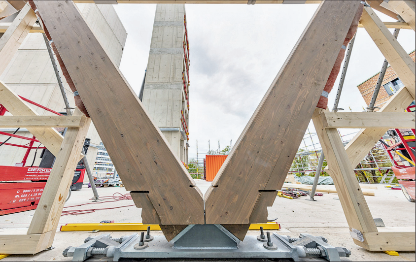
Anschluss eines Fachwerk-Fassadenträgers an den Steckverbinder Foto: Ansgar van Treeck
