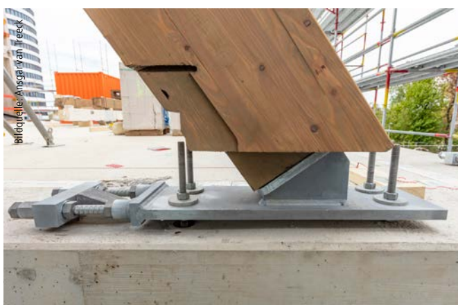
Bei der Montage in Düsseldorf wurden die Fachwerk-Fassadenelemente mittels der leim- und schraubenfreien Steckverbinder rein mechanisch zusammengesetzt.
