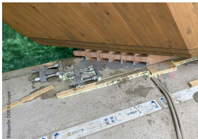
Auf die mit stählernen Kopfplatten versehenen Steckverbindungsanschlüsse der Knappe wurden die andockenden BSH-Elemente gesteckt, die über entsprechende Aussparungen verfügen. Damit nimmt die Knappe die Schubkräfte der Elemente auf und leitet diese in das jeweils parallel versetzte Bauteil weiter.
