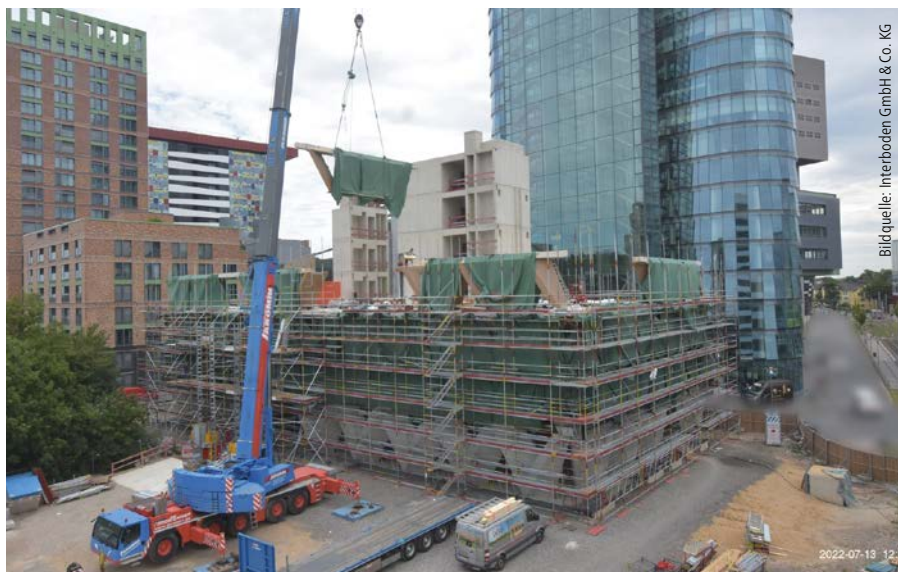
Die bis zu sechs Tonnen schweren und mit einem Maximalmaß von 17,20 m × 1,09 m × 3,49 m aufwartenden Fachwerk-Fassadenelemente wurden als Ganzes vom Kran in die Stockwerke eingehoben.
