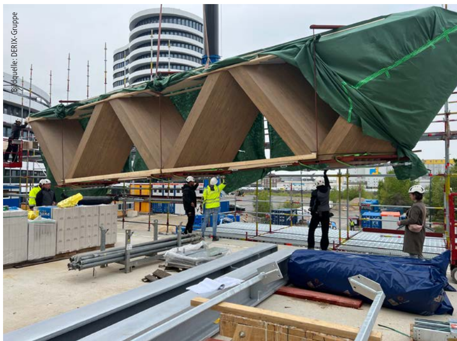
Die neue Bauteil-Steckverbindung erfordert auch eine andere Montage, damit die Steckverbindungen beim Einbau nicht auseinanderfallen. Mit einer Stahl-Hebe-Konstruktion werden die Bauteile von unten angehoben und am Punkt der Montage abgelassen.
